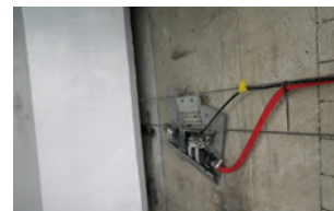
吹付ノズルと移動システム
