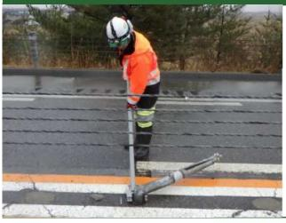
改善点①:テコの原理により1人で引き 抜き作業が可能
