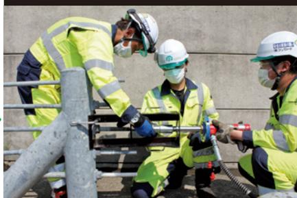
油圧引きシリンダを索端金具に固定し、油圧引きシリンダを緊張治具に密着させます。
