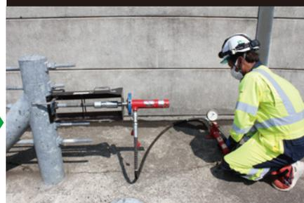
手動油圧ポンプのレバーを上下に動かして、緊張を行います。
