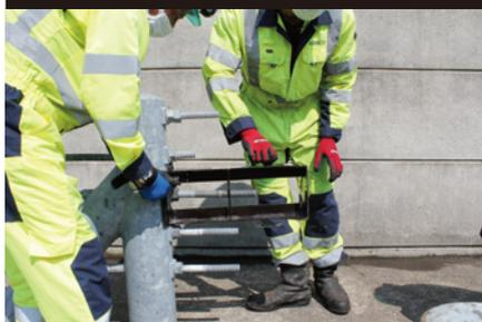
緊張治具を索端支柱にフレーム固定します。
