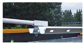
スクレーパー先端(爪)がガードレールビームの長孔に確実に引っ掛っていることが 確認できたら持ち上げる
